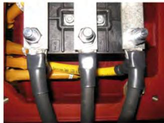
Los cables deben ser paralelos entre sí de manera que se respeten las distancias en el aire de 14mm entre fase y entre fase y tierra
